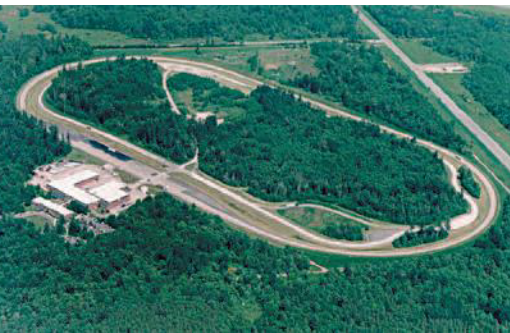
▲ Voilà une vue aérienne de la piste d'essai et de certains bâtiments du Centre technique PACCAR de Mount Vernon, dans l'état de Washington.
