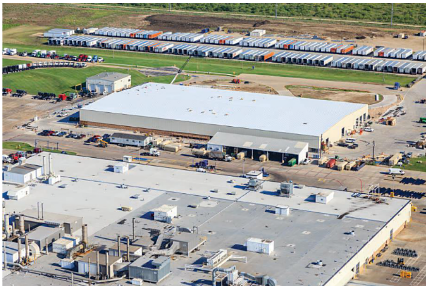
> De nouveaux bâtiments à l'usine de Peterbilt à Denton au Texas permettent d'améliorer les opérations manufacturières.
